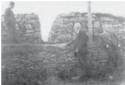
Blick von Osten auf die Schlupfporte, das sog. „Sonnenloch“, in der Westringmauer. Aufnahme von ca. 1937. Foto: Sammlung W. Bleicher.
